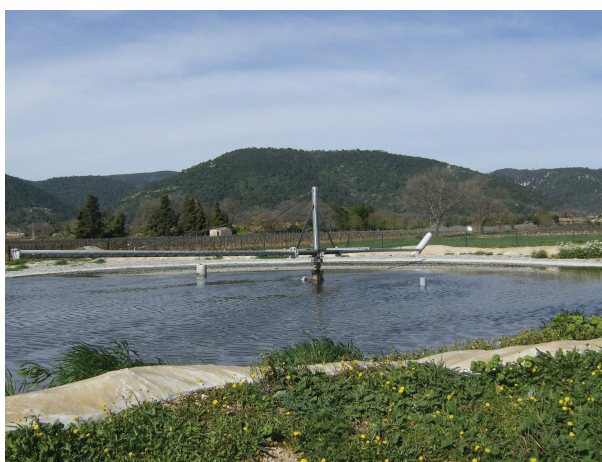
Lit d'infiltration saturé
